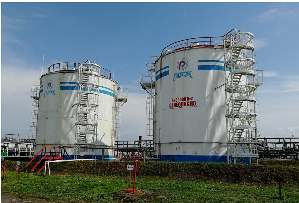
Рисунок 1 - Общий вид резервуаров вертикальных цилиндрических сварных РВС-1000
