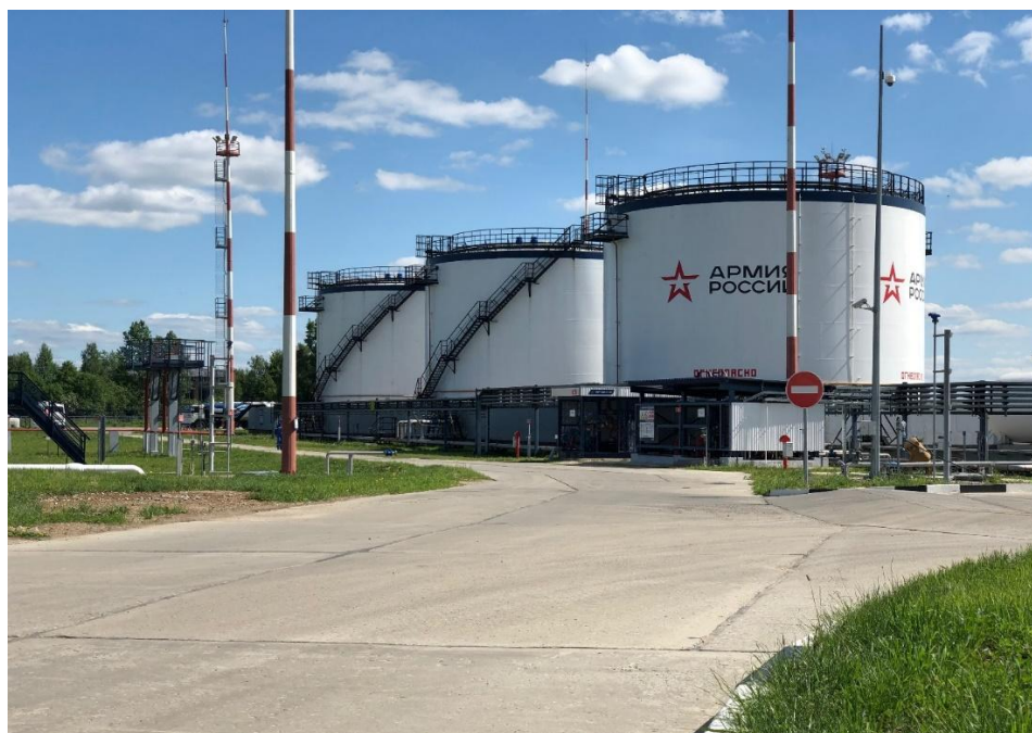
Рисунок 1 – Общий вид резервуаров РВС-3700 №№ 1, 2, 3
