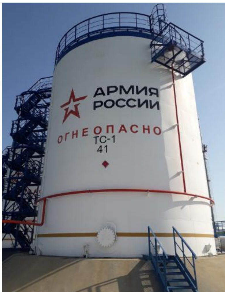
Рисунок 1 – Общий вид резервуара РВС-1000
