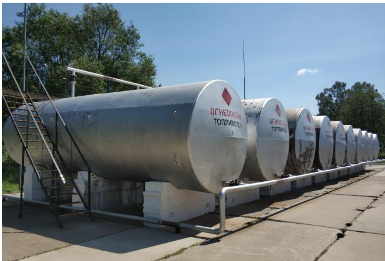
Рисунок 1 – Общий вид резервуаров РГС-50
