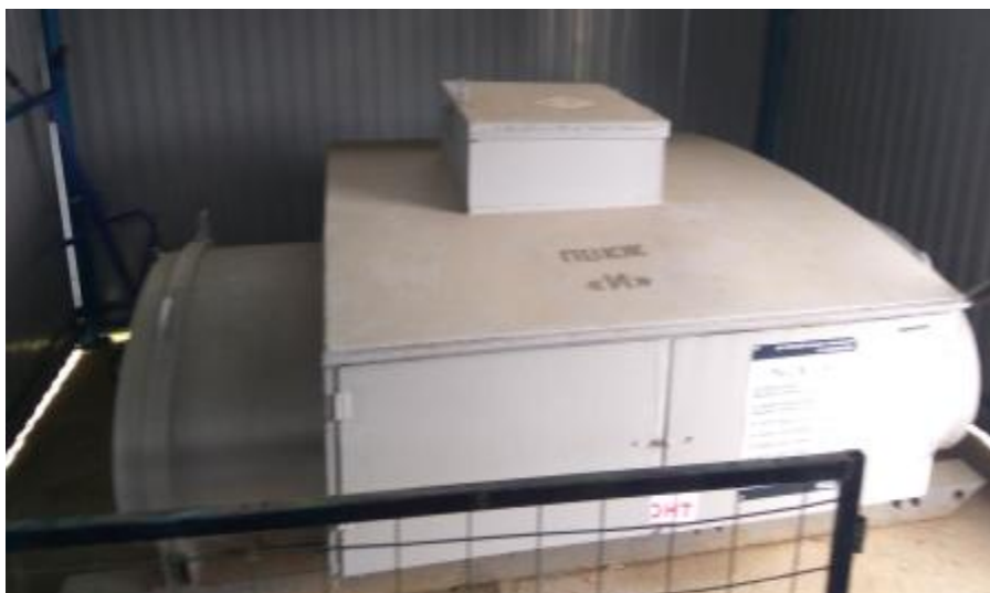
Рисунок 2 – Общий вид резервуара РГС-2
