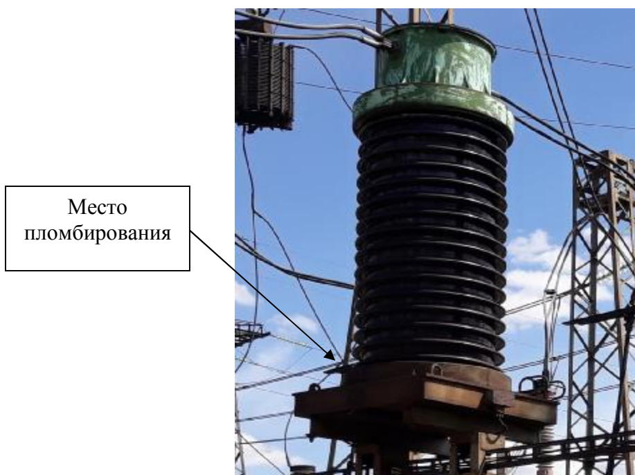
Рисунок 1 - Общий вид трансформаторов с обозначением места пломбирования
