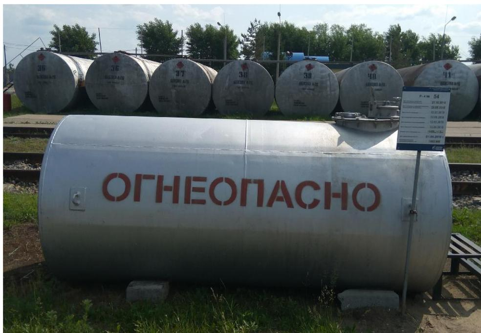
Рисунок 1 – Общий вид резервуаров стальных горизонтальных цилиндрических РГС-4, РГС-10, РГС-25, РГС-50
