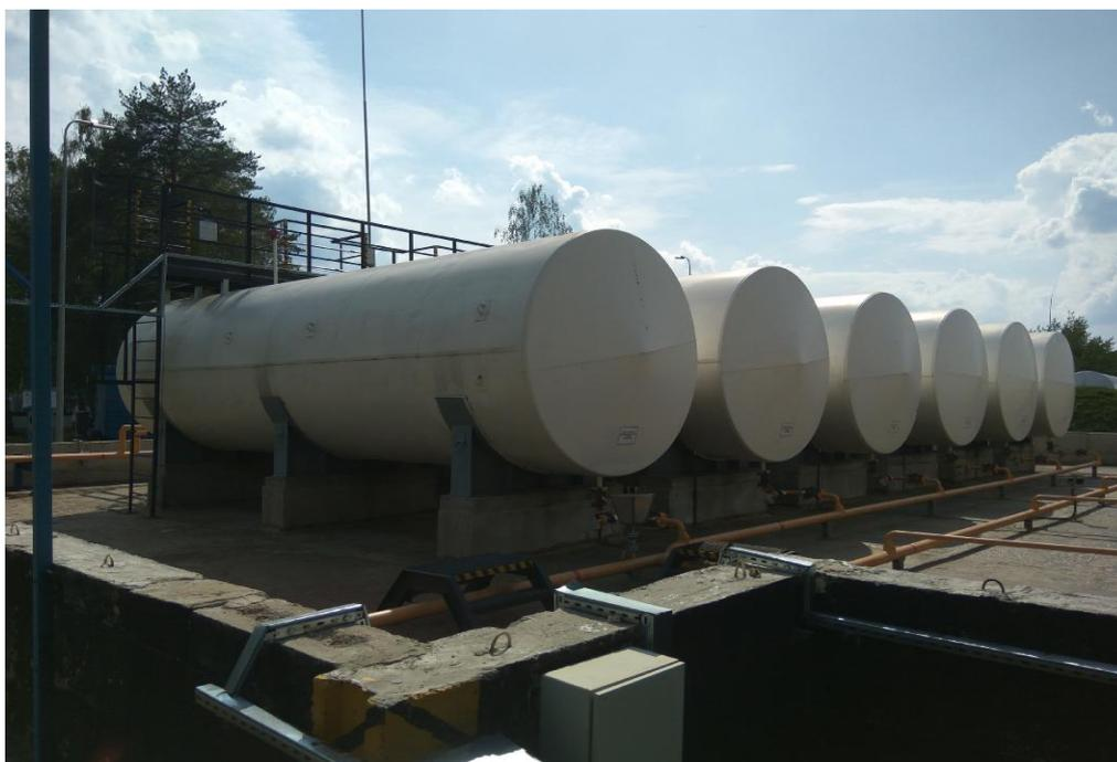
Рисунок 1 – Общий вид резервуаров стальных горизонтальных цилиндрических РГС-5, РГС-10, РГС-50
