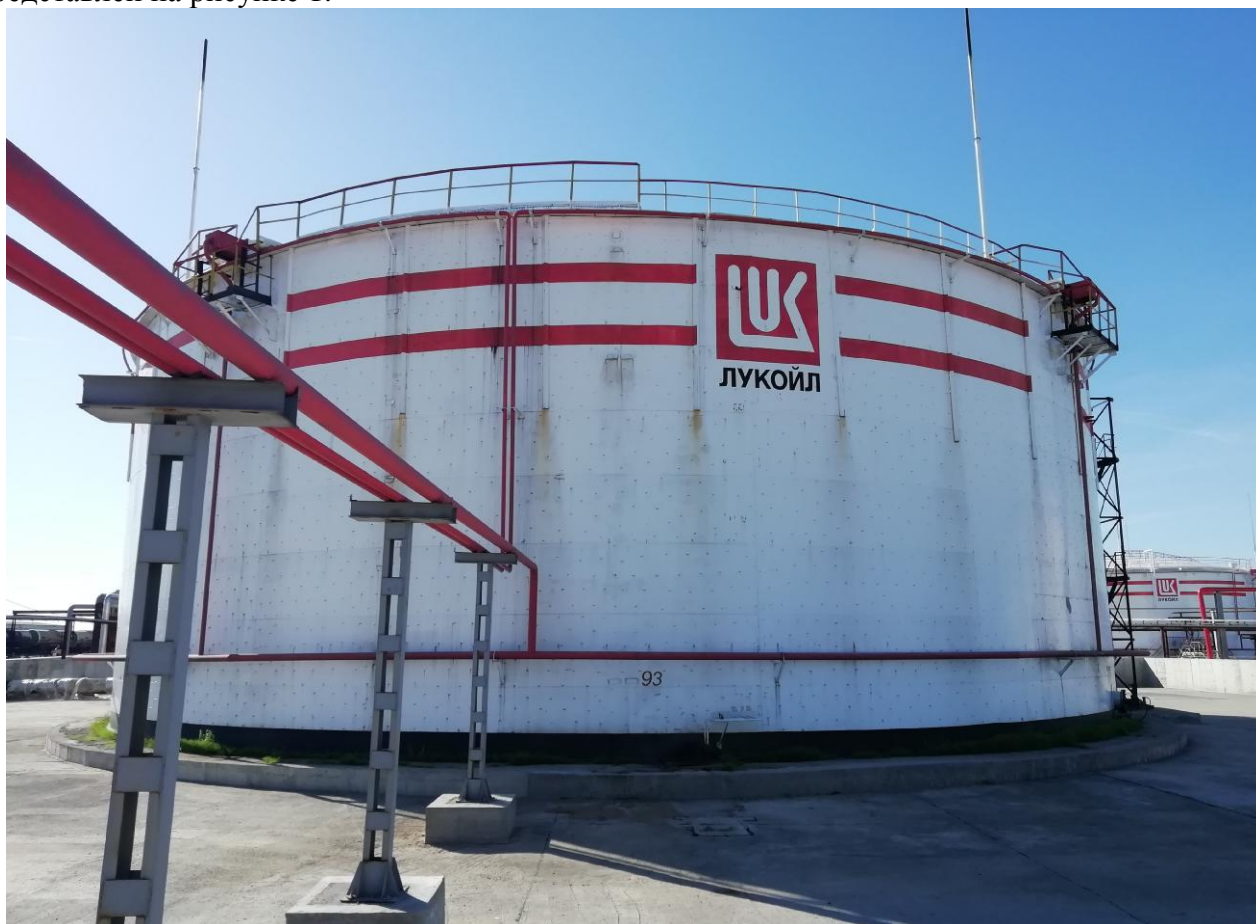
Рисунок 1 – Общий вид резервуара РВС-10000
