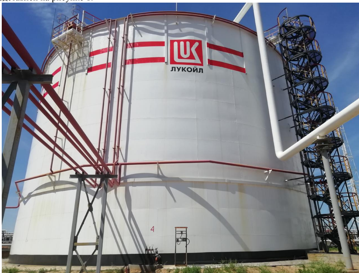
Рисунок 1 – Общий вид резервуара РВС-10000
