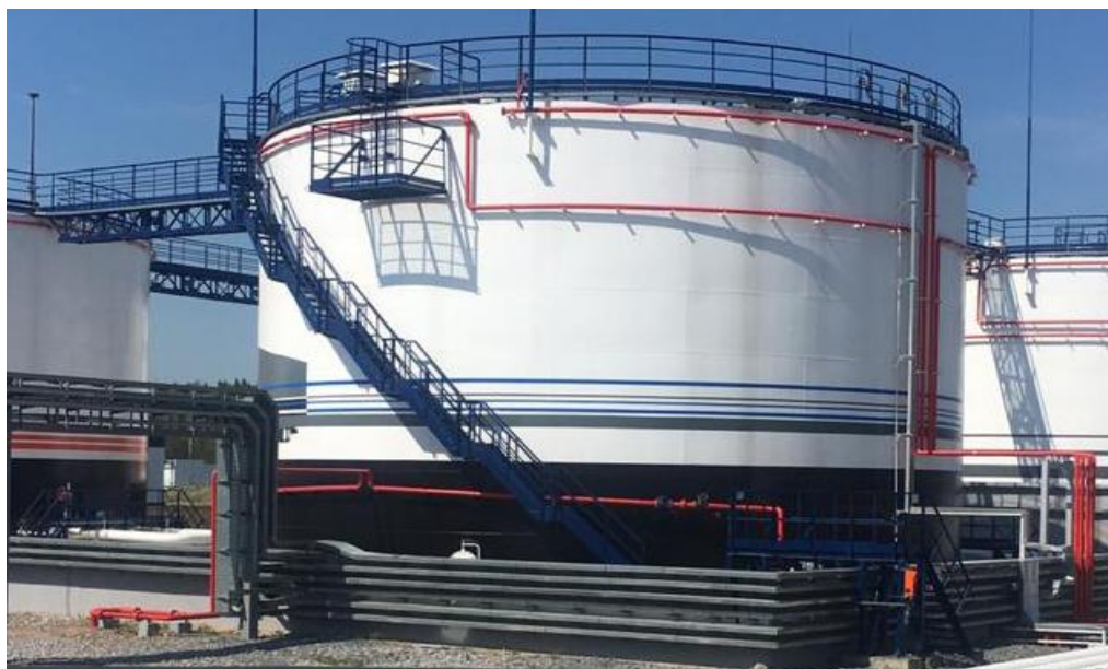
Рисунок 1 – Общий вид резервуара вертикального стального цилиндрического РВС-3000
