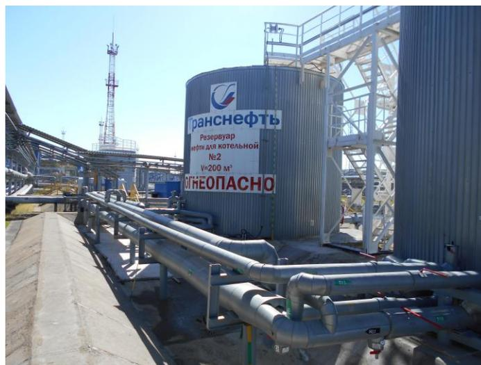
Рисунок 2 - Общий вид резервуара РВС-200 № 108.2
