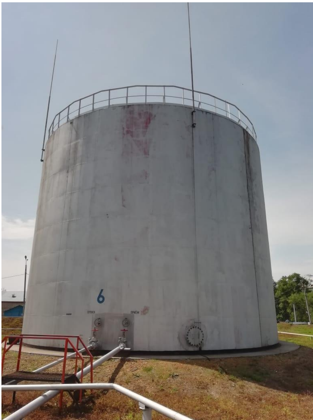
Рисунок 1 – Общий вид резервуара стального вертикального цилиндрического РВСП-2000
