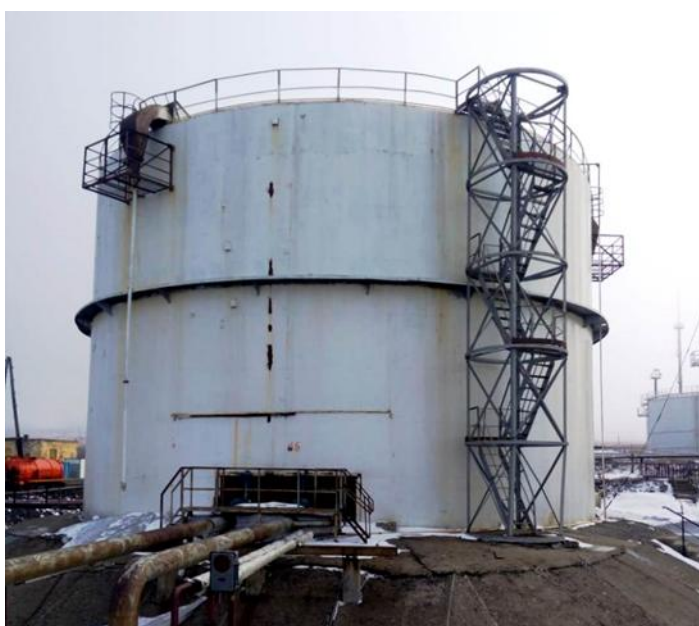
Рисунок 1 – Общий вид резервуара РВС-3000 с зав.№ СЗ-37
