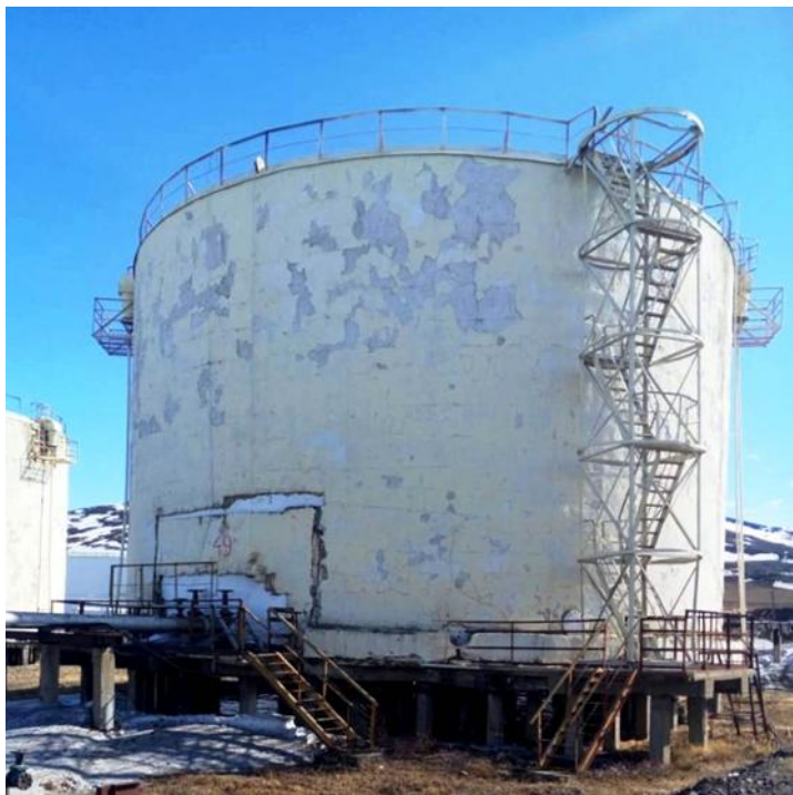
Рисунок 2 – Общий вид резервуаров РВС-3000 с зав.№№ СЗ-22, СЗ-24
