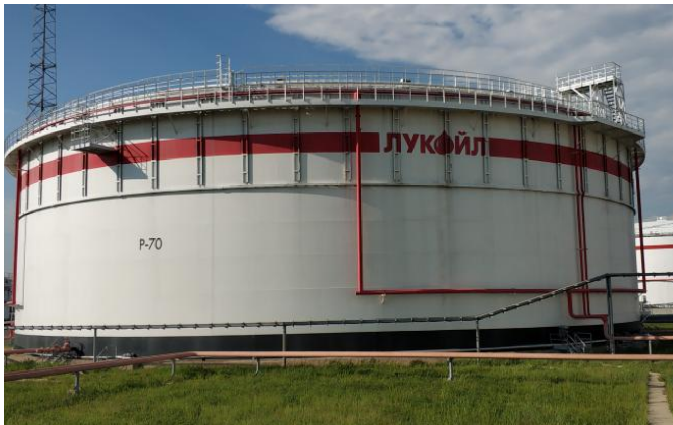
Рисунок 1 – Общий вид резервуара РВСП-50000
