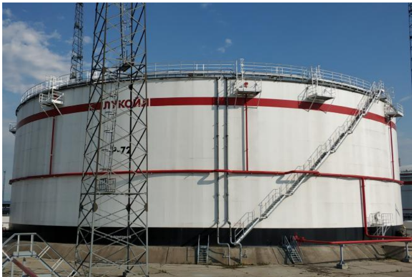
Рисунок 1 – Общий вид резервуара РВСП-50000
