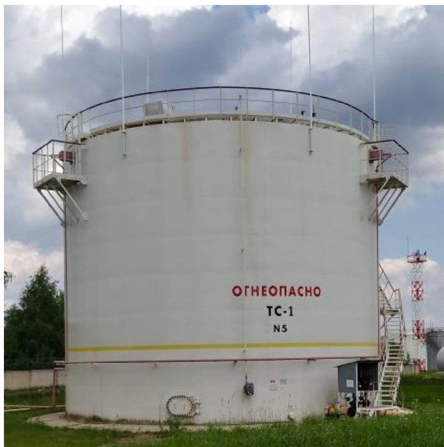
Рисунок 1 - Общий вид резервуаров вертикальных стальных цилиндрических РВС-2000
