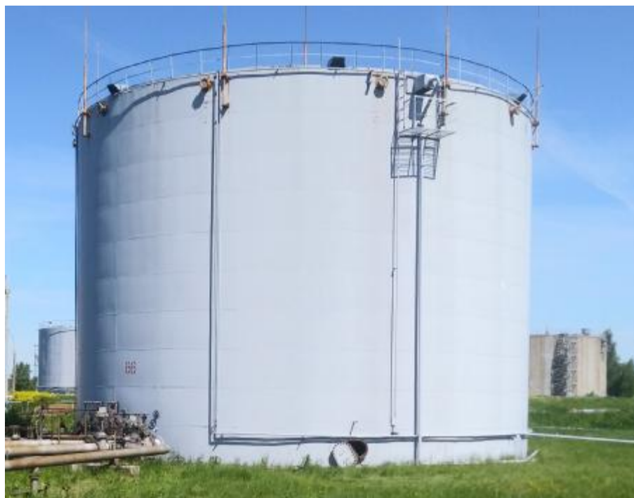
Рисунок 2 - Общий вид резервуара вертикального стального цилиндрического PVC-5000, состоящего из 10 поясов
