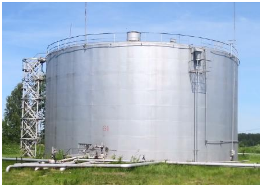
Рисунок 1 - Общий вид резервуаров вертикальных стальных цилиндрических РВС-5000, состоящих из 8 поясов
