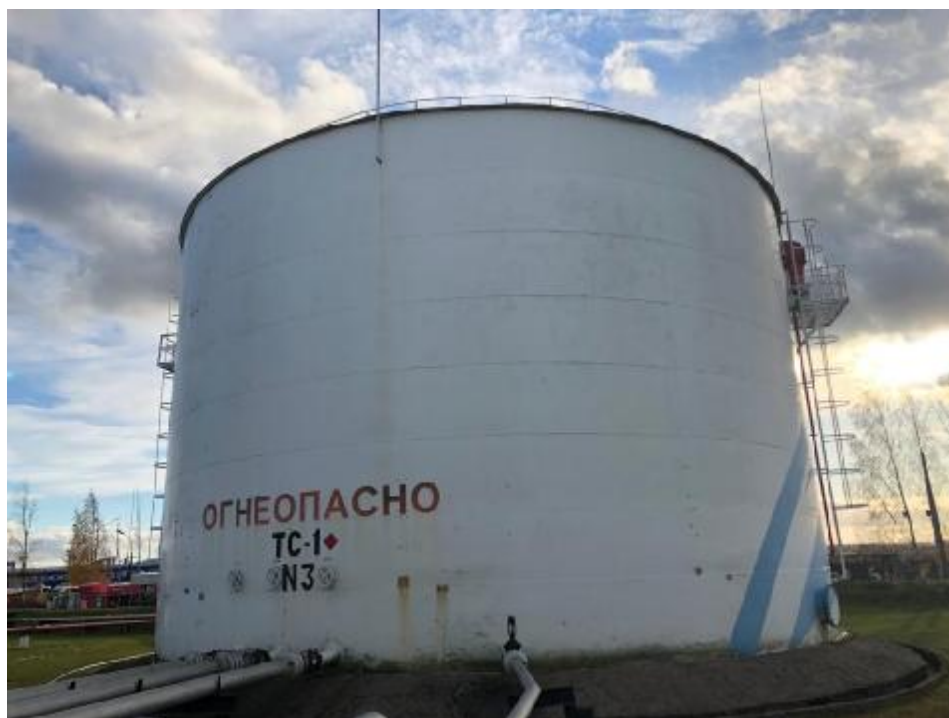
Рисунок 1 – Общий вид резервуаров стальных вертикальных цилиндрических РВС-3000
