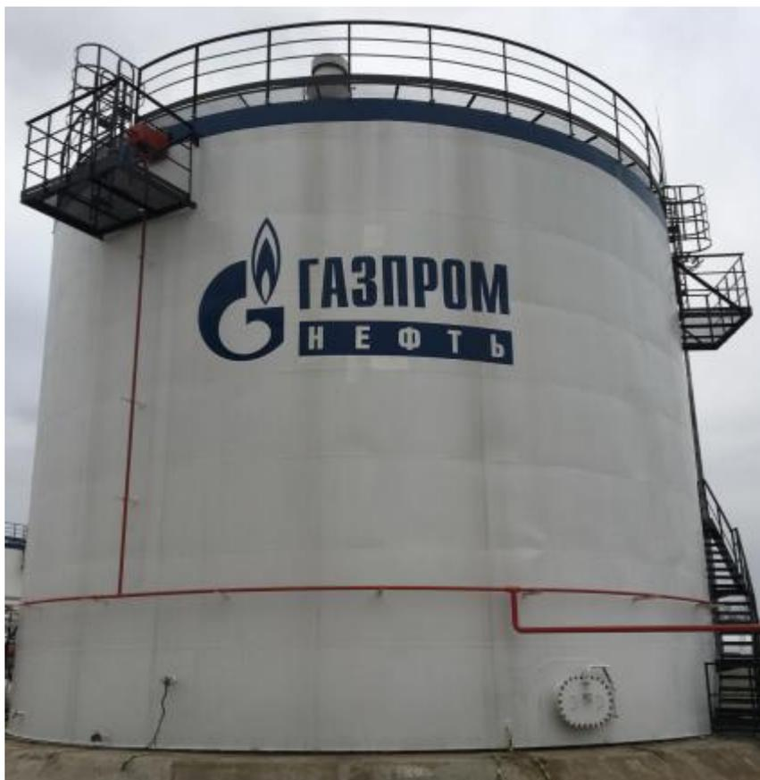
Рисунок 2 – Общий вид резервуаров стальных вертикальных цилиндрических РВС-2000
