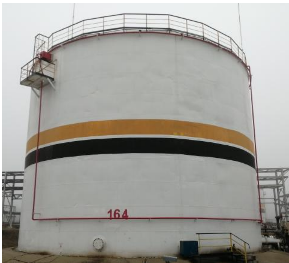
Рисунок 1 – Общий вид резервуара стального вертикального цилиндрического РВС-5000
