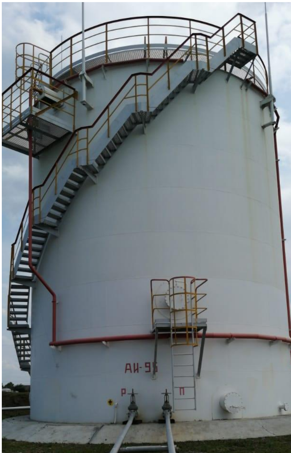
Рисунок 1 – Общий вид резервуара стального вертикального цилиндрического РВСП-1000
