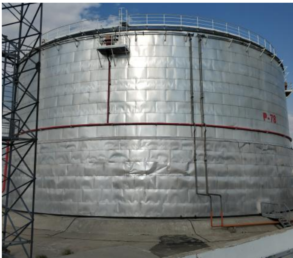
Рисунок 1 – Общий вид резервуара РВС-20000
