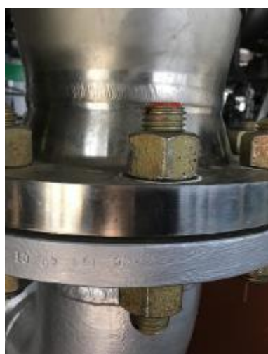
Рисунок 1 – Схема пломбировки расходомера массового Promass с первичным преобразователем расхода (датчиком) Promass F и электронным преобразователем 83
