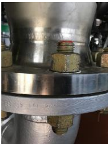
Рисунок 1 – Схема пломбировки массомеров
