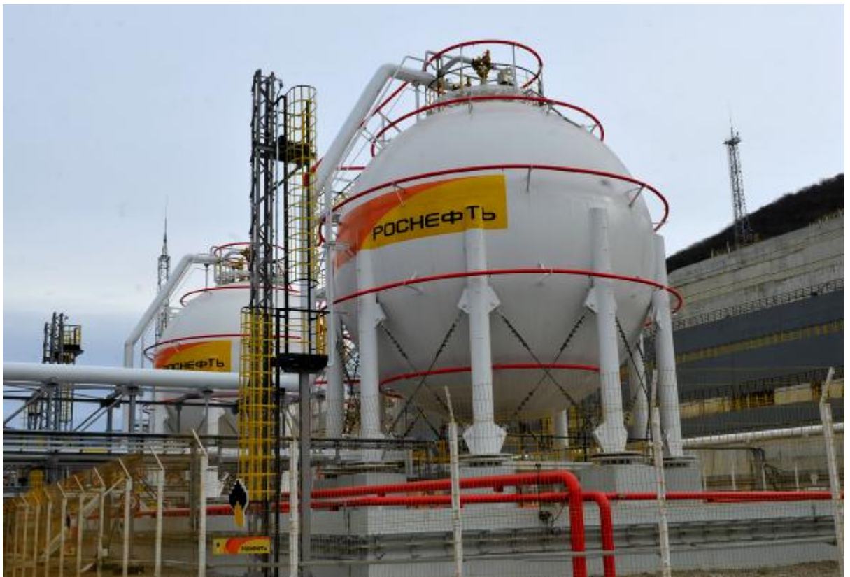
Рисунок 1 - Общий вид резервуаров
