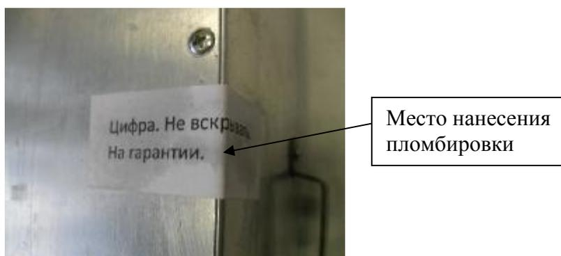
Рисунок 2 – Место нанесения пломбировки от несанкционированного доступа.
