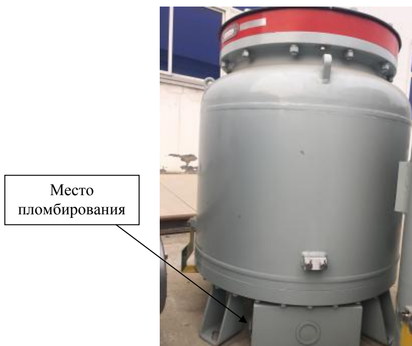
Рисунок 1 - Общий вид трансформаторов с указанием места пломбирования от несанкционированного доступа
