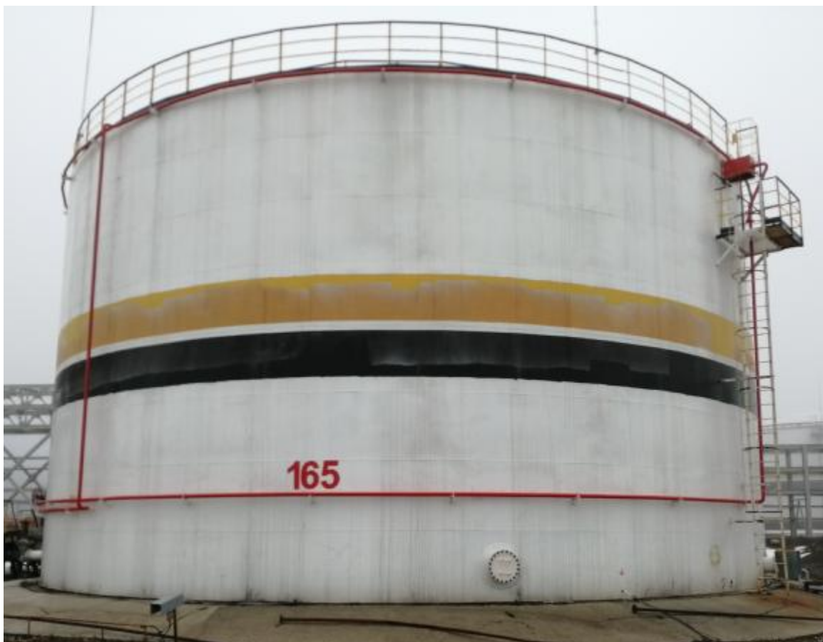
Рисунок 1 – Общий вид резервуара стального вертикального цилиндрического РВС-5000
