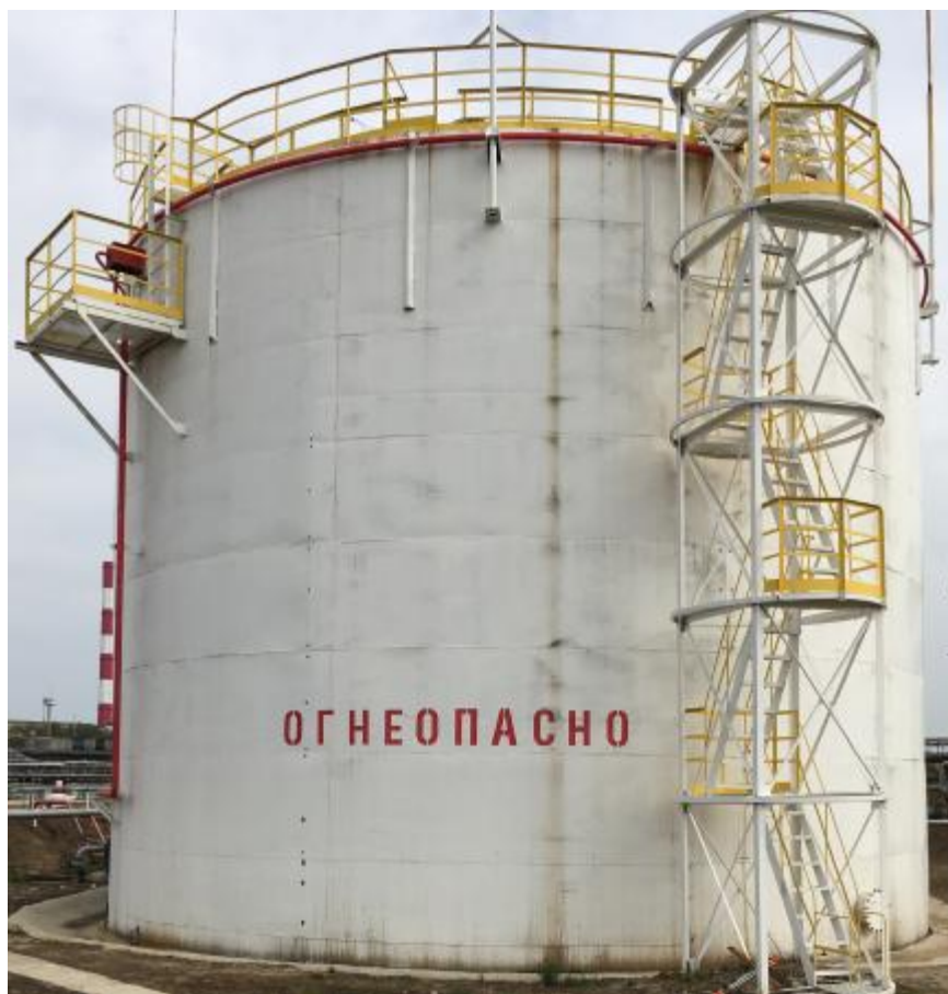
Рисунок 1 – Общий вид резервуара стального вертикального цилиндрического РВС-2000
