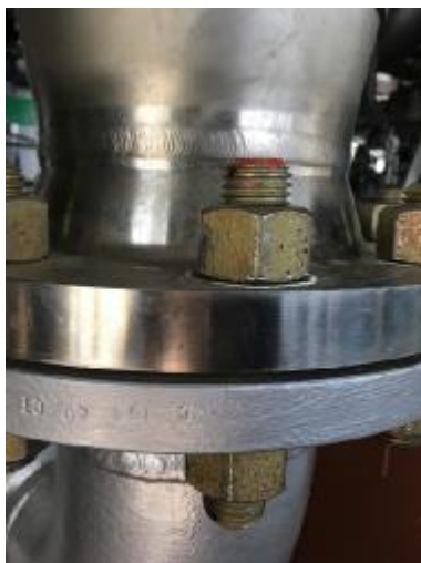
Рисунок 1 – Схема пломбировки массомера
