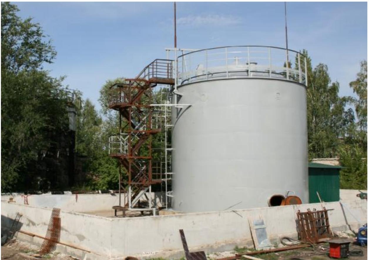
Рисунок 1 - Резервуар вертикальный стальной РВС-400 №1К
