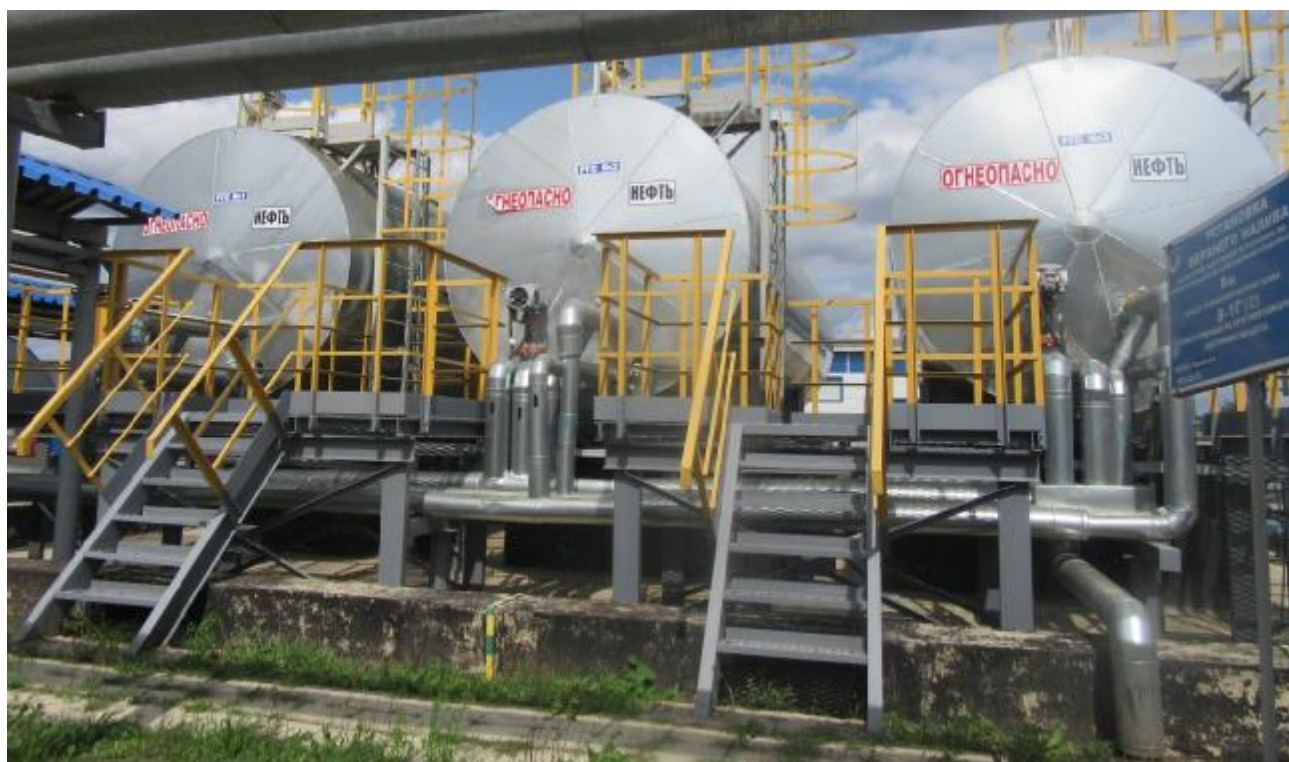
Рисунок 3 – Общий вид резервуаров горизонтальных стальных цилиндрических РГС-50 зав. № 6597, 6598, 6599
