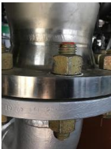
Рисунок 1 – Схема пломбировки массомера
