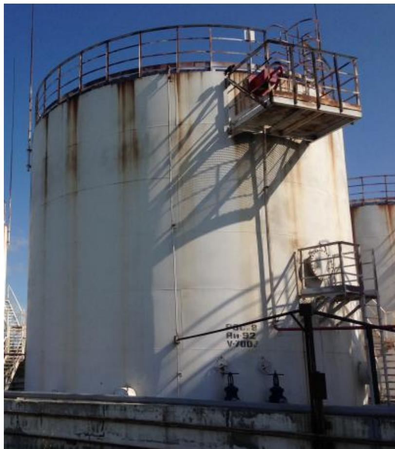
Рисунок 2 – Общий вид резервуара вертикального стального цилиндрического РВСП-700
