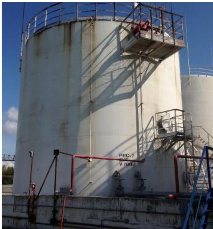
Рисунок 1 – Общий вид резервуара вертикального стального цилиндрического РВС-700
