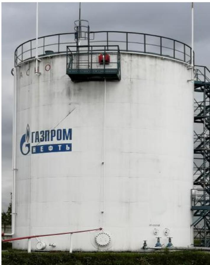
Рисунок 2 – Общий вид резервуара вертикального стального цилиндрического РВС-1000
