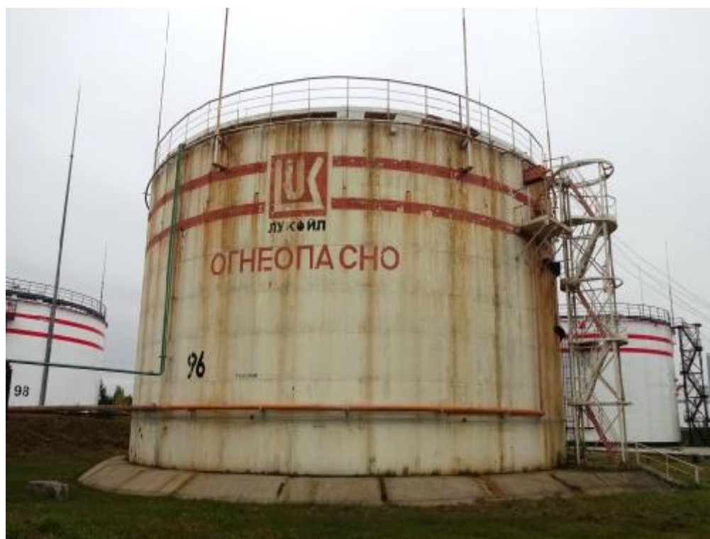
Рисунок 1 – Общий вид резервуара РВСП-5000 № 96
