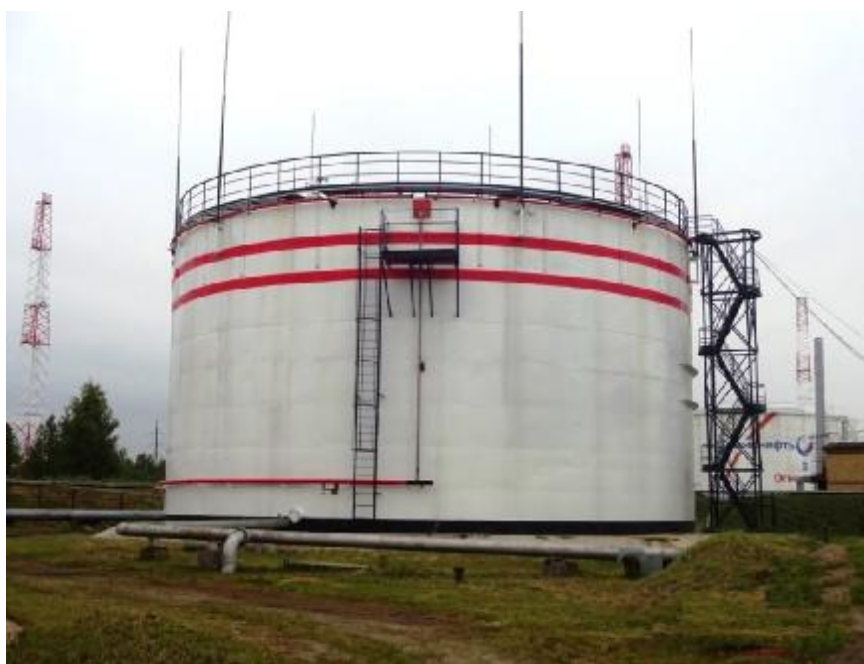
Рисунок 1 – Общий вид резервуаров РВСП-5000 №№ 92, 95
