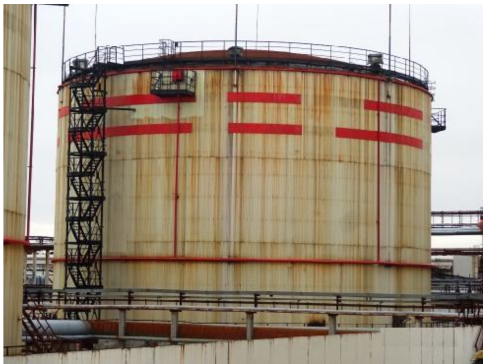
Рисунок 2 – Общий вид резервуаров РВС-10000 № 260, 265
