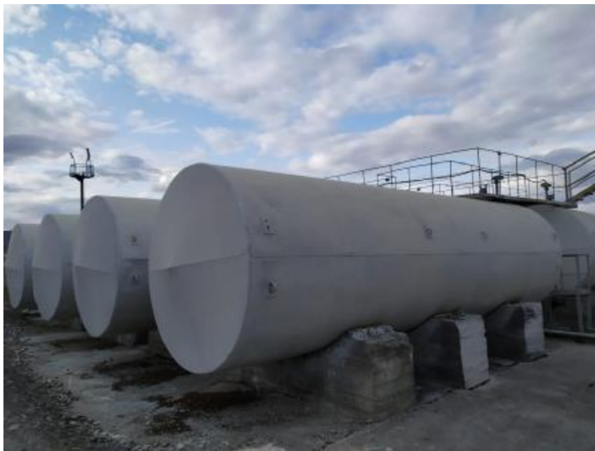
Рисунок 1 – Общий вид резервуаров РГС-50
