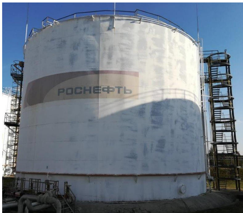
Рисунок 4 – Общий вид резервуара стального вертикального цилиндрического РВСП-5000
