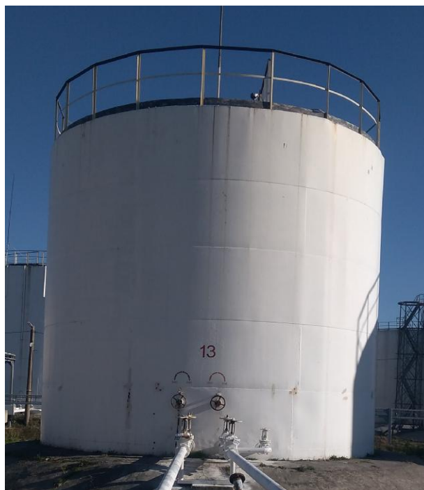
Рисунок 1 – Общий вид резервуара стального вертикального цилиндрического РВС-400
