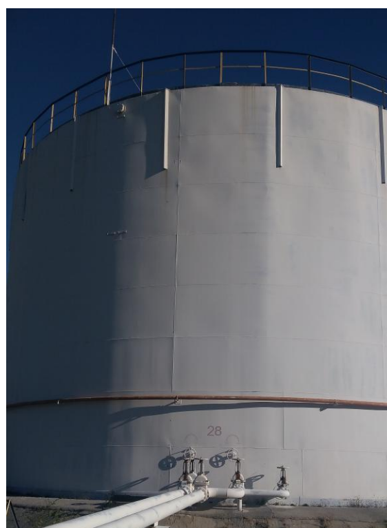
Рисунок 3 – Общий вид резервуара стального вертикального цилиндрического РВС-3000, РВСП-3000
