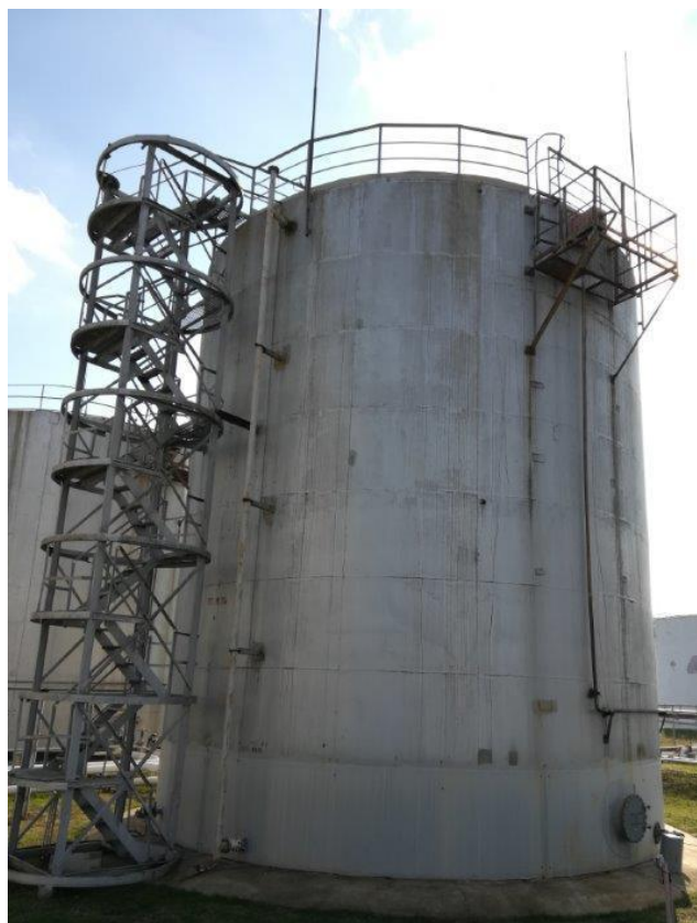
Рисунок 2 – Общий вид резервуара стального вертикального цилиндрического РВСП-1000
