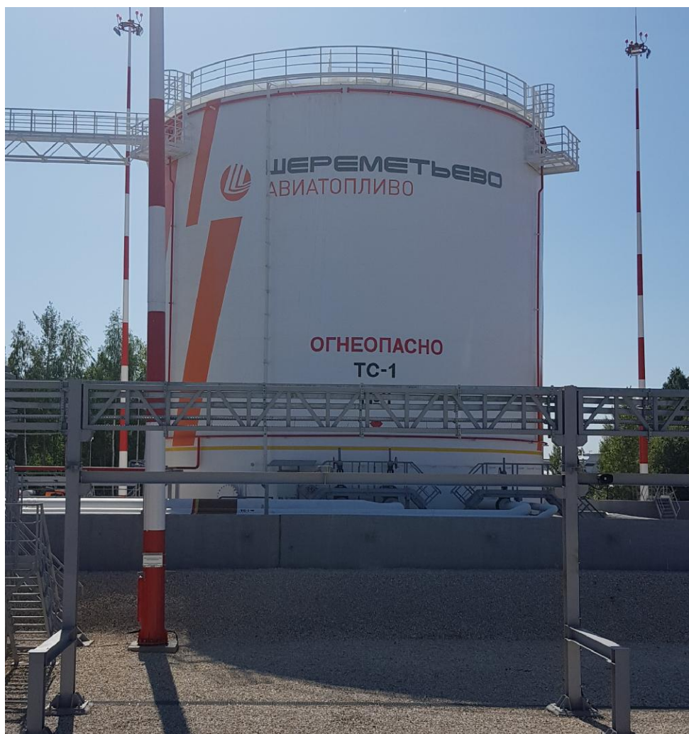
Рисунок 1 – Общий вид резервуаров РВС-5000
