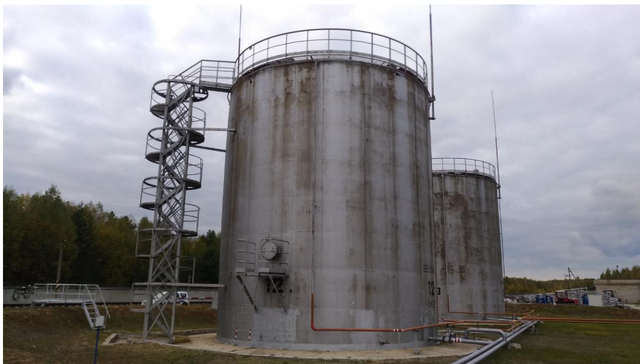
Рисунок 1 – Общий вид резервуара вертикального стального цилиндрического с понтоном РВСП-1000
