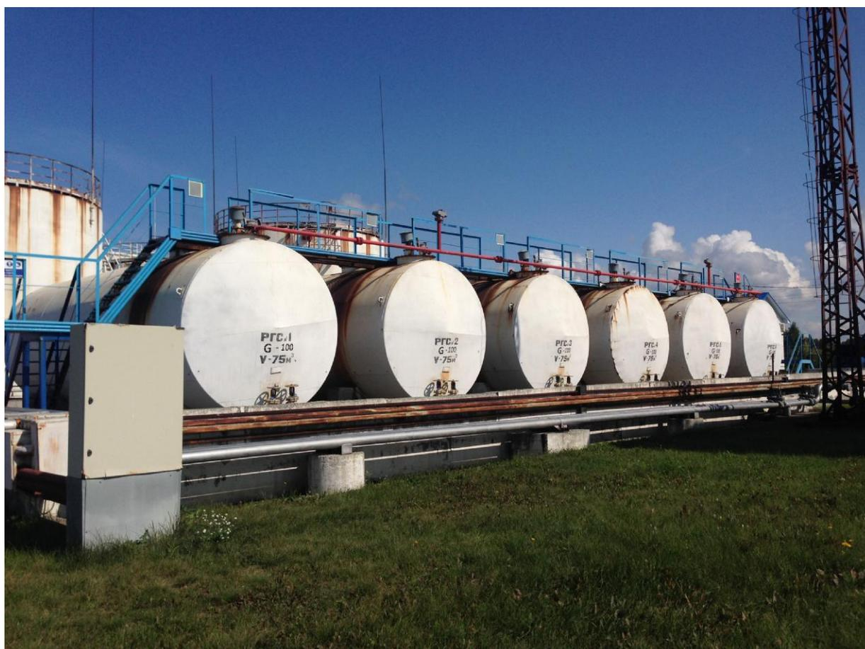
Рисунок 1 – Общий вид резервуаров горизонтальных стальных цилиндрических РГС-75
