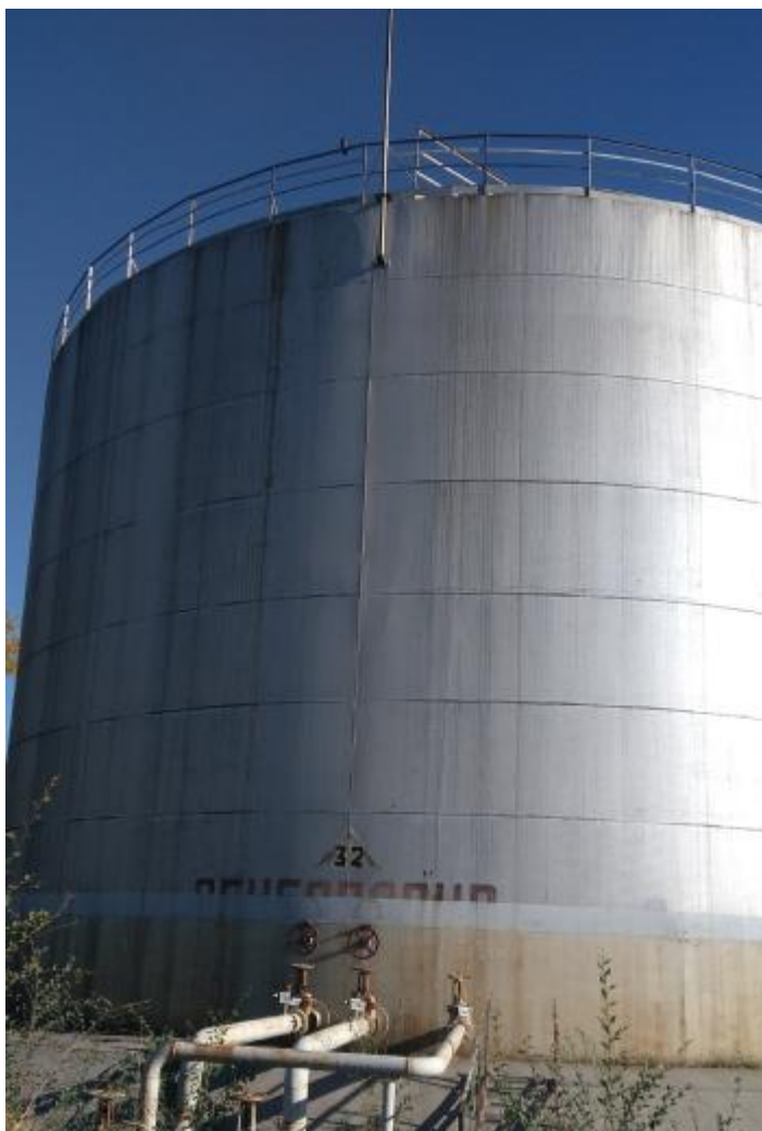
Рисунок 2 – Общий вид резервуара стального вертикального цилиндрического РВС-3000
