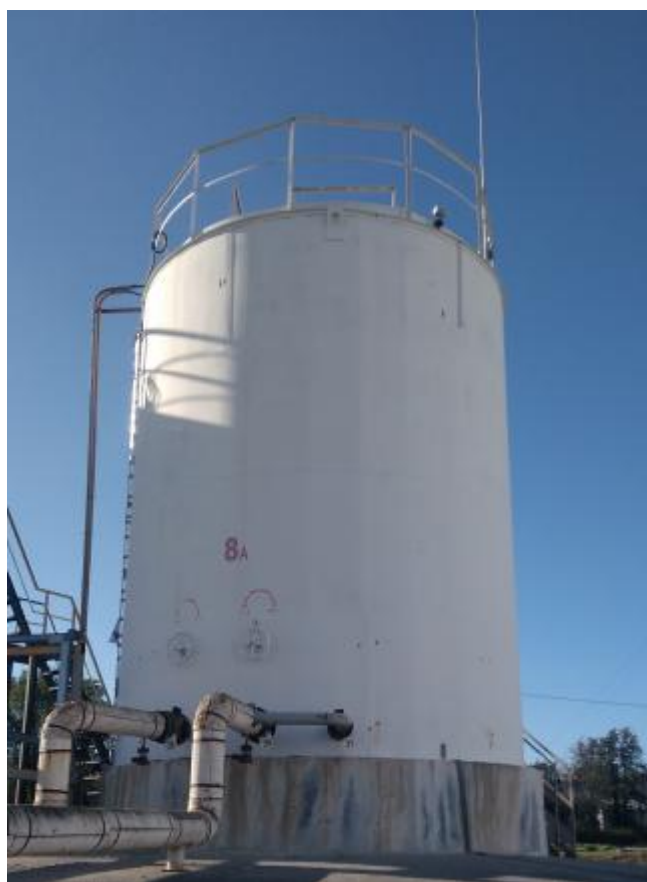
Рисунок 1 – Общий вид резервуара стального вертикального цилиндрического РВС-100, РВСП-100
