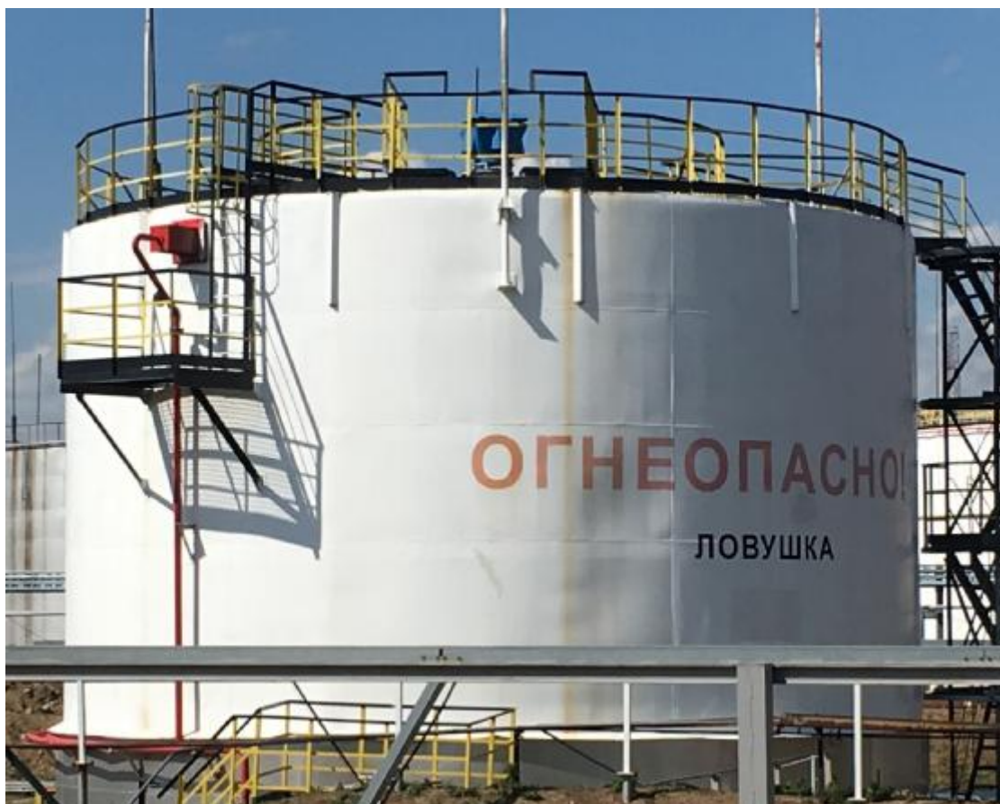
Рисунок 1 – Общий вид резервуара стального вертикального цилиндрического РВС-1000
