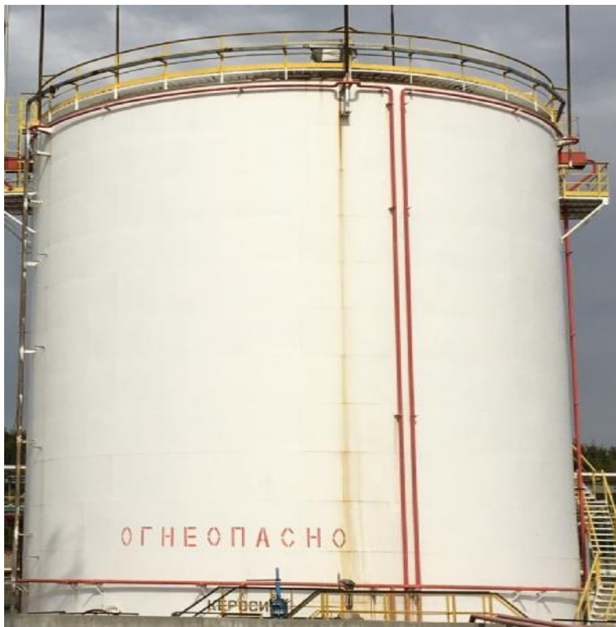
Рисунок 1 – Общий вид резервуара стального вертикального цилиндрического РВС-3000
