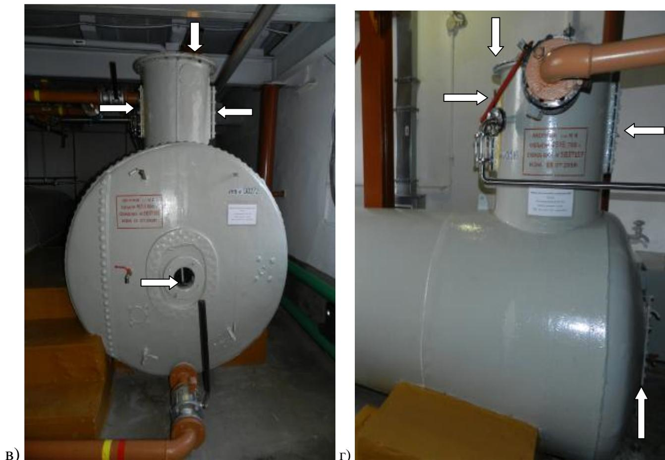
Рисунок 2 – Схема пломбировки мерников ММГ от несанкционированного доступа
