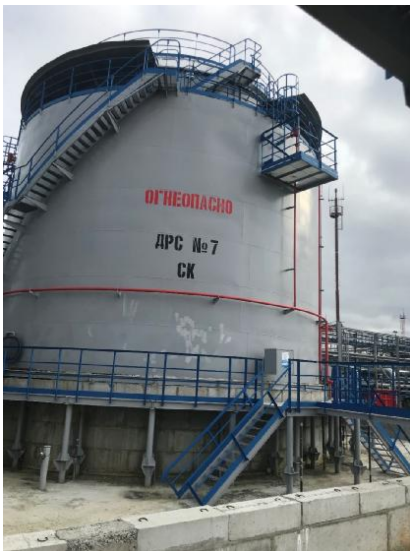
Рисунок 1 – Общий вид резервуаров
