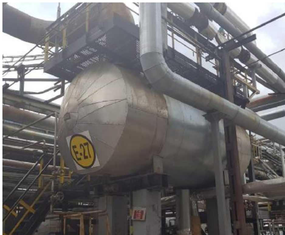
Рисунок 2 – Общий вид резервуара стального горизонтального цилиндрического РГС-27
