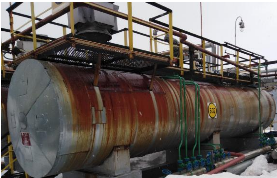
Рисунок 1 – Общий вид резервуара стального горизонтального цилиндрического РГС-18, РГС-27, РГС-45
