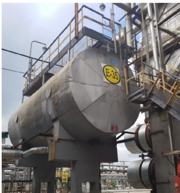
Рисунок 3 – Общий вид резервуара стального горизонтального цилиндрического РГС-45
