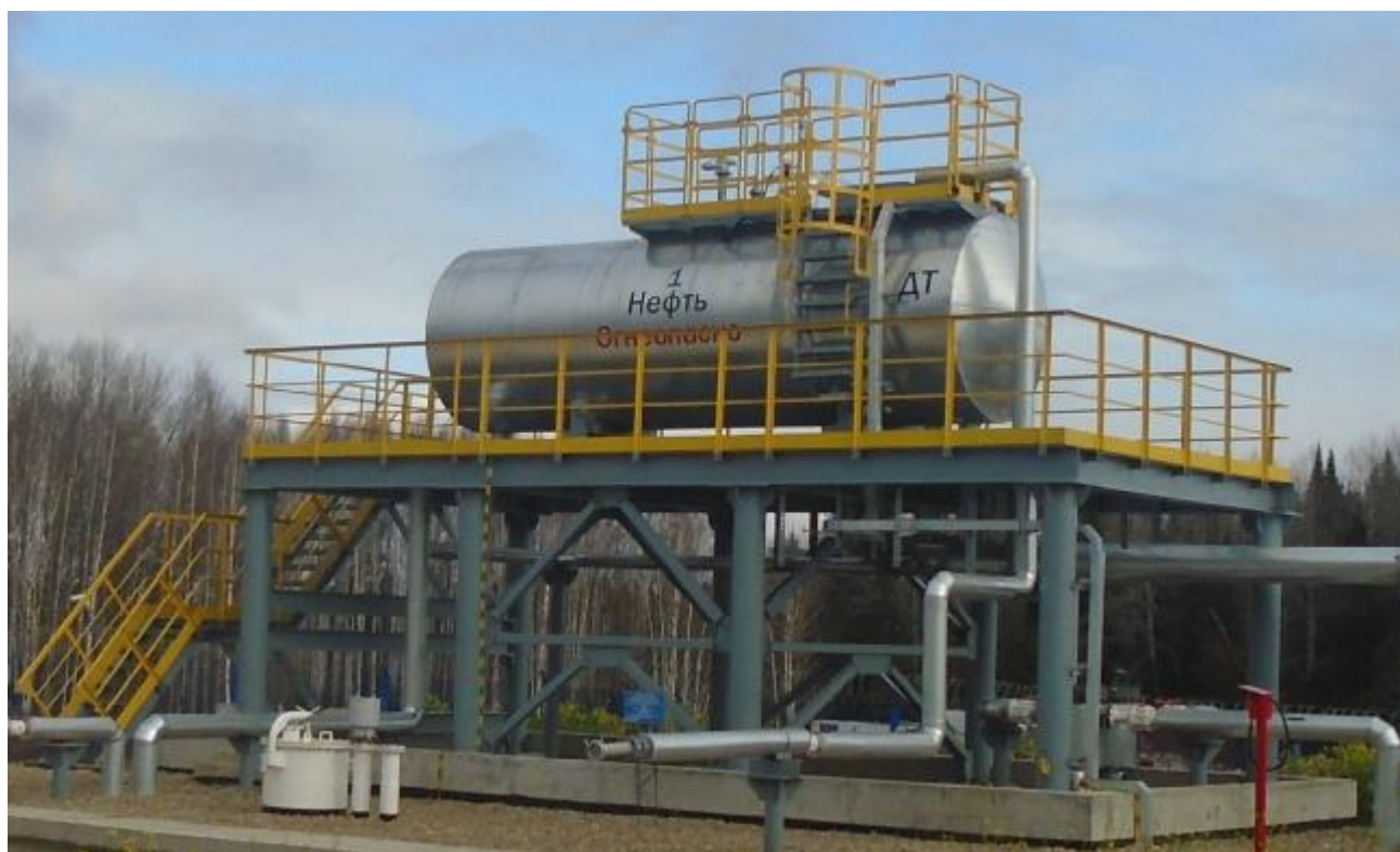
Рисунок 1 – Общий вид резервуара РГС-20
